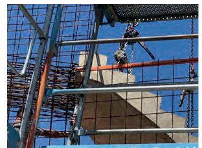
Positionierung bei dynamischen Lasten
